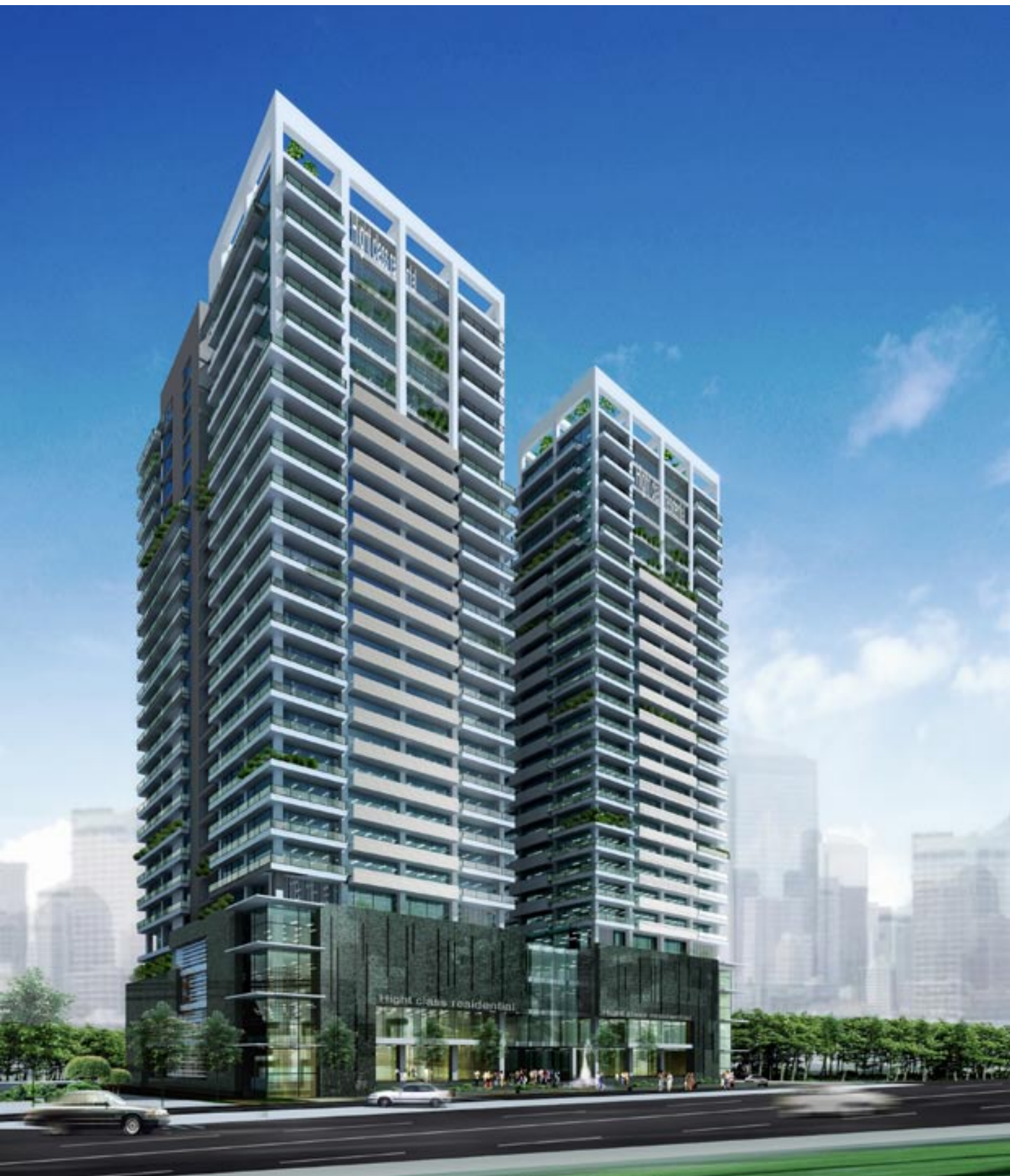
29 floors - High class residential building Đi Trạch - Hoài Đức - Hà Nội
